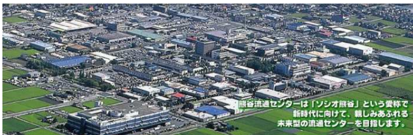
熊谷流通センター全景
